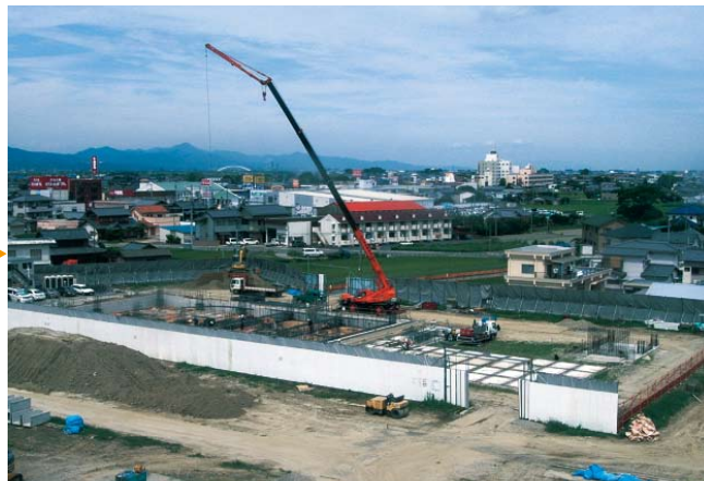
平成23年7月：雨水貯留槽躯体工事
