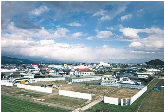
平成23年2月：仮設工事
