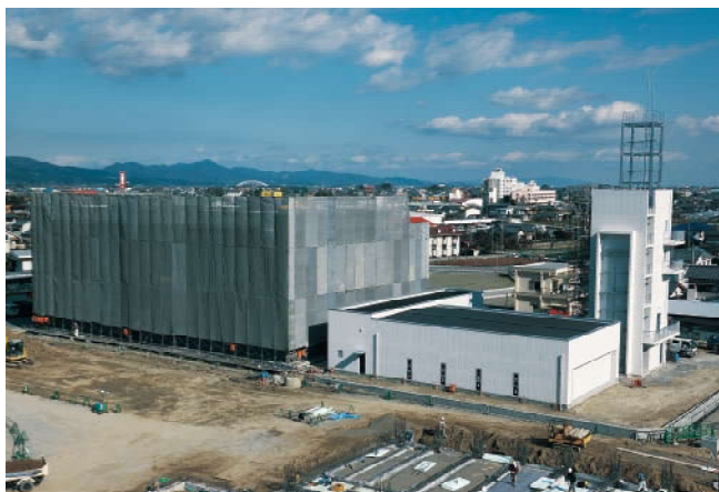
平成24年1月：全景写真(工事進捗率約80%)
