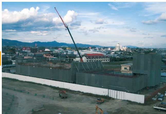
平成23年9月：1階躯体工事
